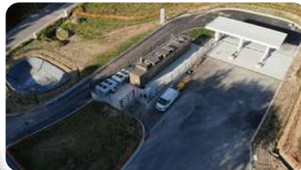
Station de Saint Gérard Capacité de distribution : 970 Nm 3 /h
